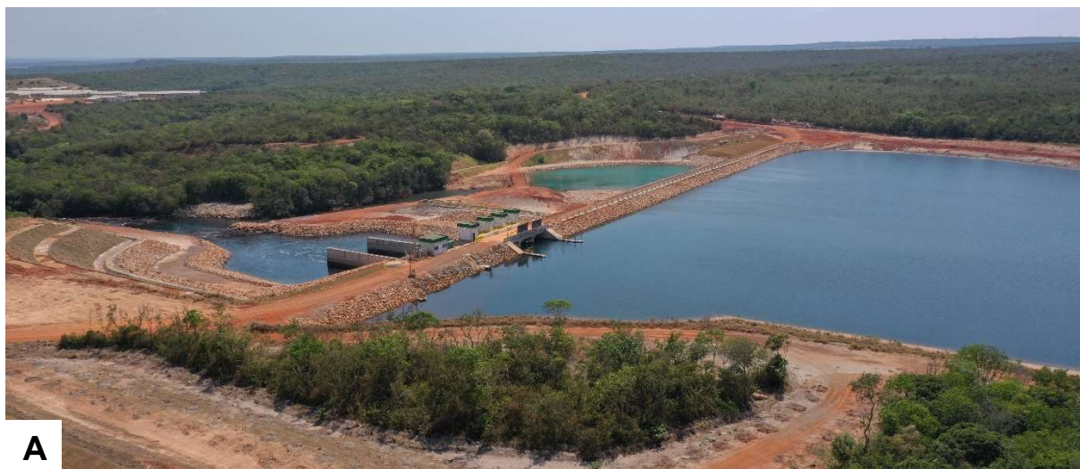
Figura 09. Vistas de estruturas hidráulicas da UHE Juruena, Campos de Júlio e Sapezal – MT. Barramento (A, B e C), vertedouro (A, B e C) e canal de adução (C).
