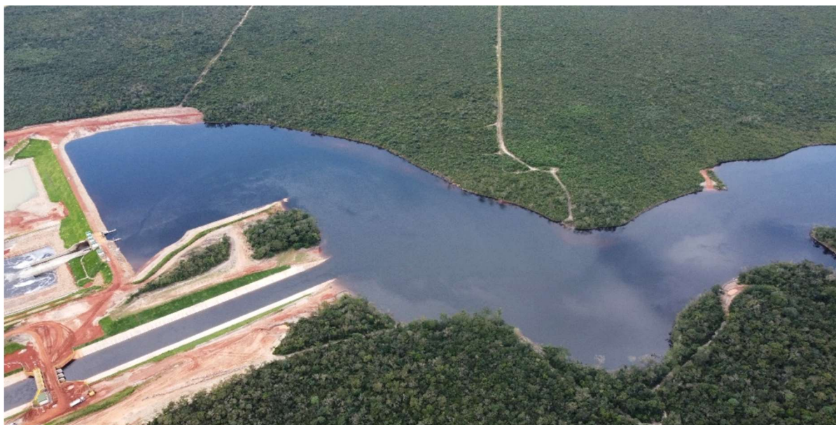
Figura 34. Vista aérea parcial do reservatório, em abril de 2025, após o enchimento, UHE Juruena, Campos de Júlio e Sapezal – MT.
