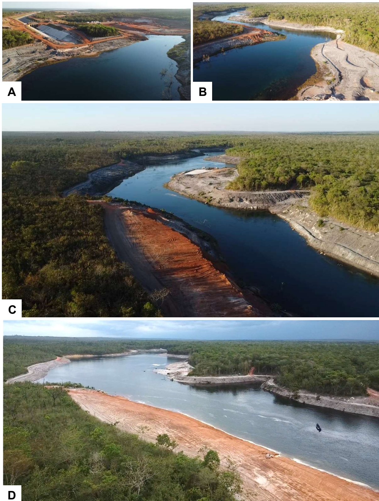
Figura 33. Vistas aéreas da limpeza das áreas no entorno do barramento, tomada d'água (A) e reservatório (B e C), em julho de 2024 e enchimento do reservatório (D), em novembro de 2024, UHE Juruena, Campos de Júlio e Sapezal – MT.
